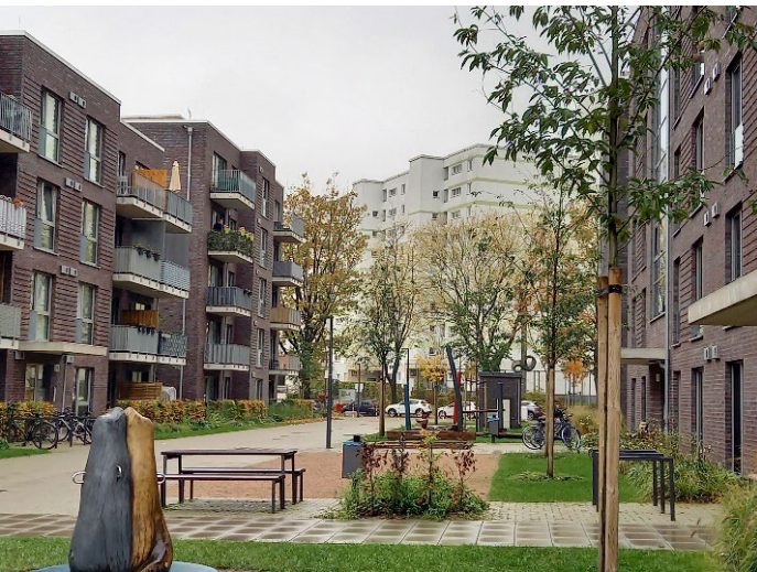
Neubau und Freiraumgestaltung in Hamburg-Eidelstedt
