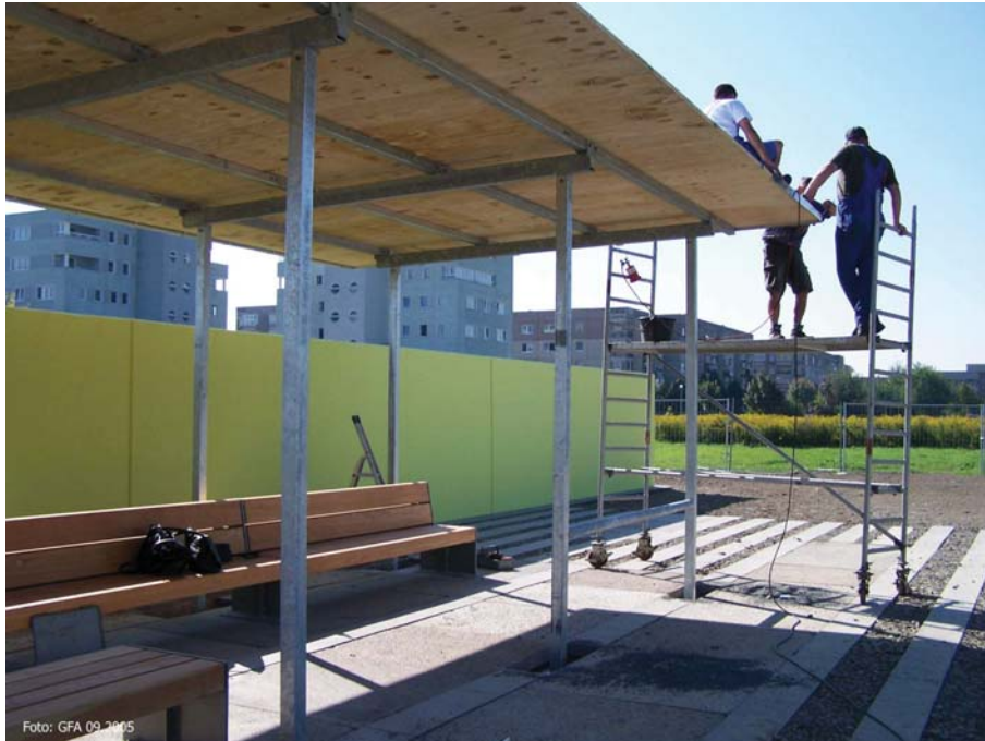
Foto: GFA 09.2005 (JT-Baustelle-07.09.2005.jpg) Grünflächenamt
