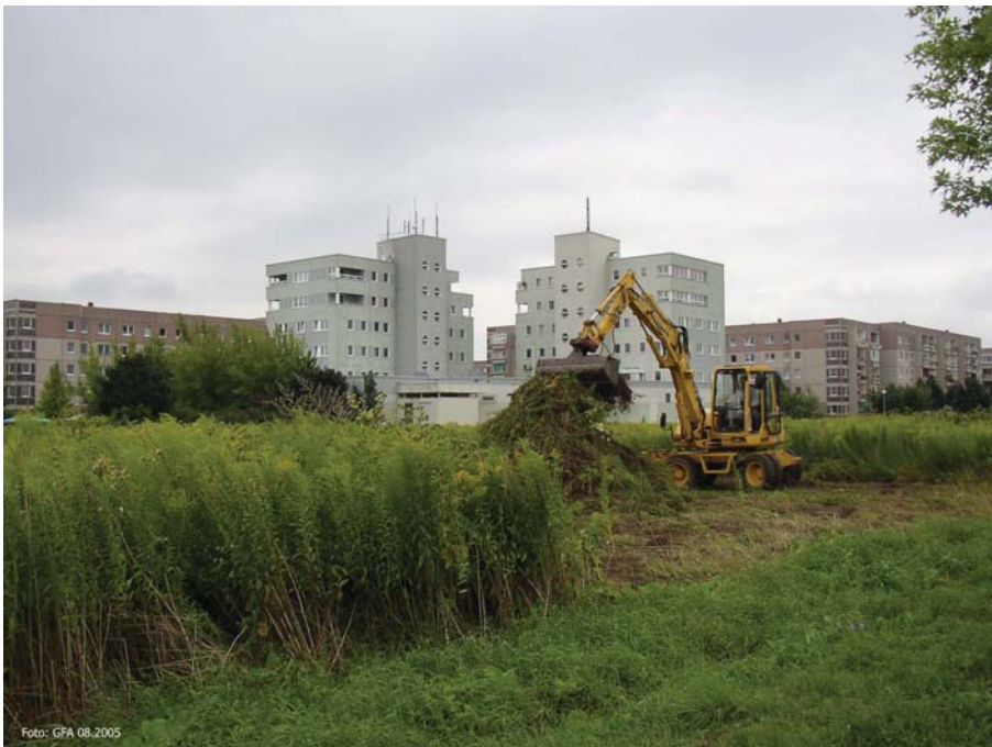
Foto: GFA 08.2005 (JT_Baustelle-Baubeginn-08.08.2005.jpg) Grünflächenamt
