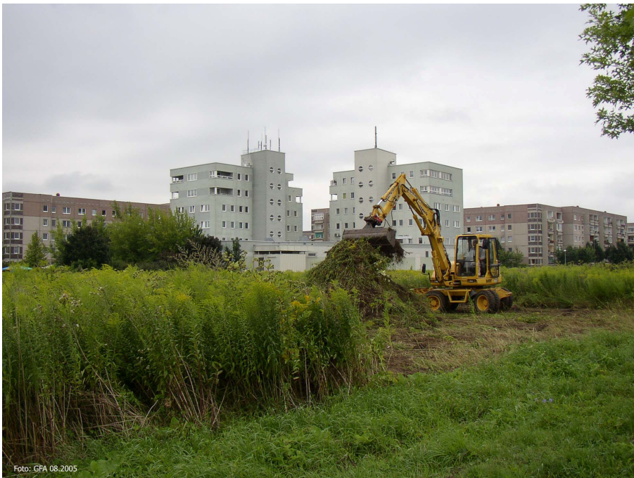
Foto: GFA 08.2005 (JT_Baustelle-Baubeginn-08.08.2005.jpg) Grünflächenamt
