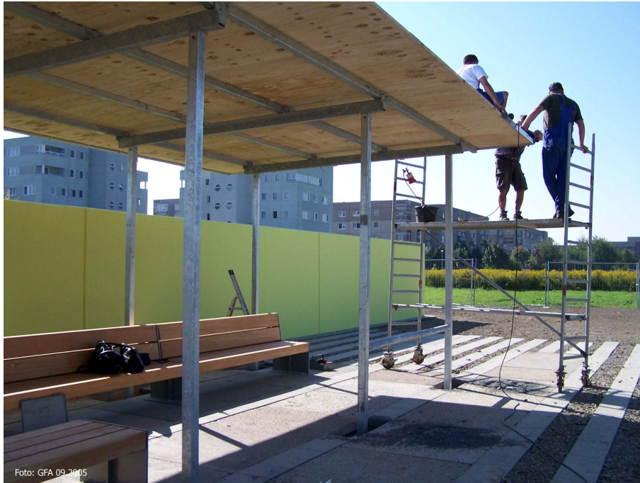
Foto: GFA 09.2005 (JT-Baustelle-07.09.2005.jpg) Grünflächenamt
