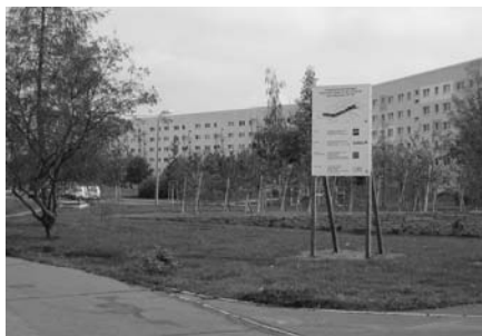
Abbildung 10: Aufwertung einer Abrissfläche in Leipzig-Grünau.
